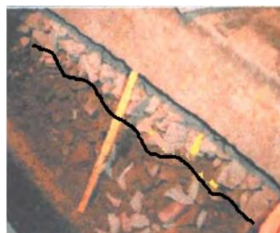
Рисунок 7 – Фрагмент радарограми і розкопаний забруднений баластний шар [9]: а) – радарограма; б) – забруднений баластний шар
