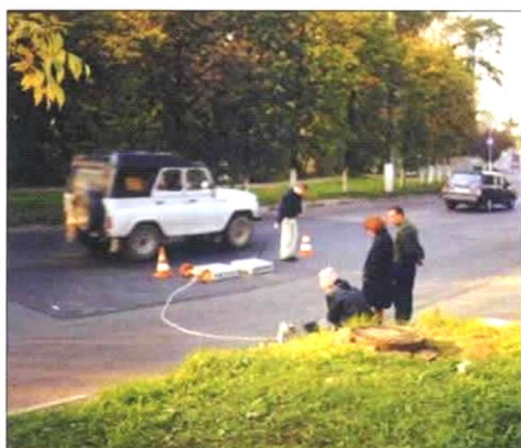
Рисунок 6 – Зондування місця провалу на автодорозі та його результат [43]
